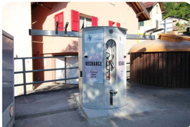
Bornes de recharge à Daillon
