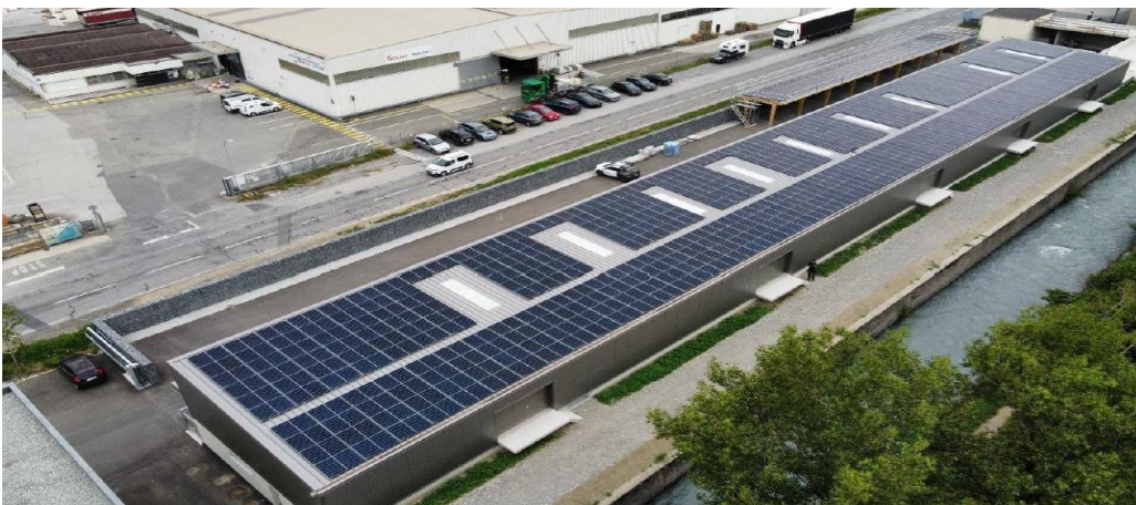
Figure 6 : toiture de la Halle des Pinèdes
